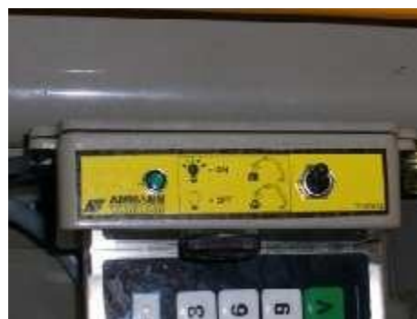
Panel kontrolny zaworów zabezpieczających z diodą alarmową i sygnałem alarmowym
